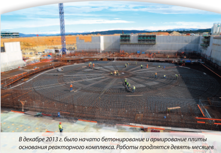
Завершение подготовки фундамента реакторного комплекса ITER
