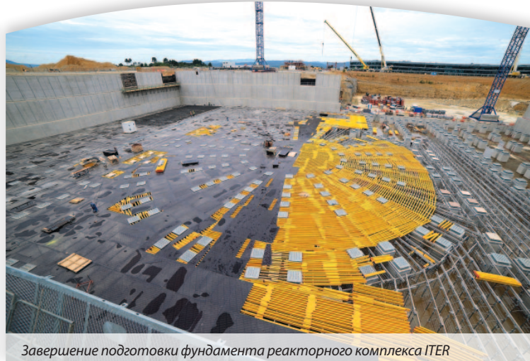
В декабре 2013 г. было начато бетонирование и армирование плиты основания реакторного комплекса. Работы продлятся девять месяцев
